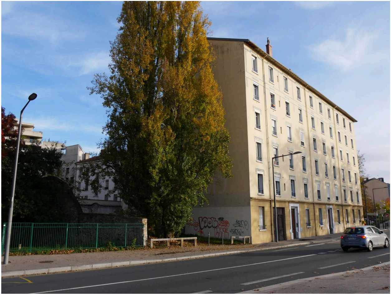
Pignon nord angle quai Serin
