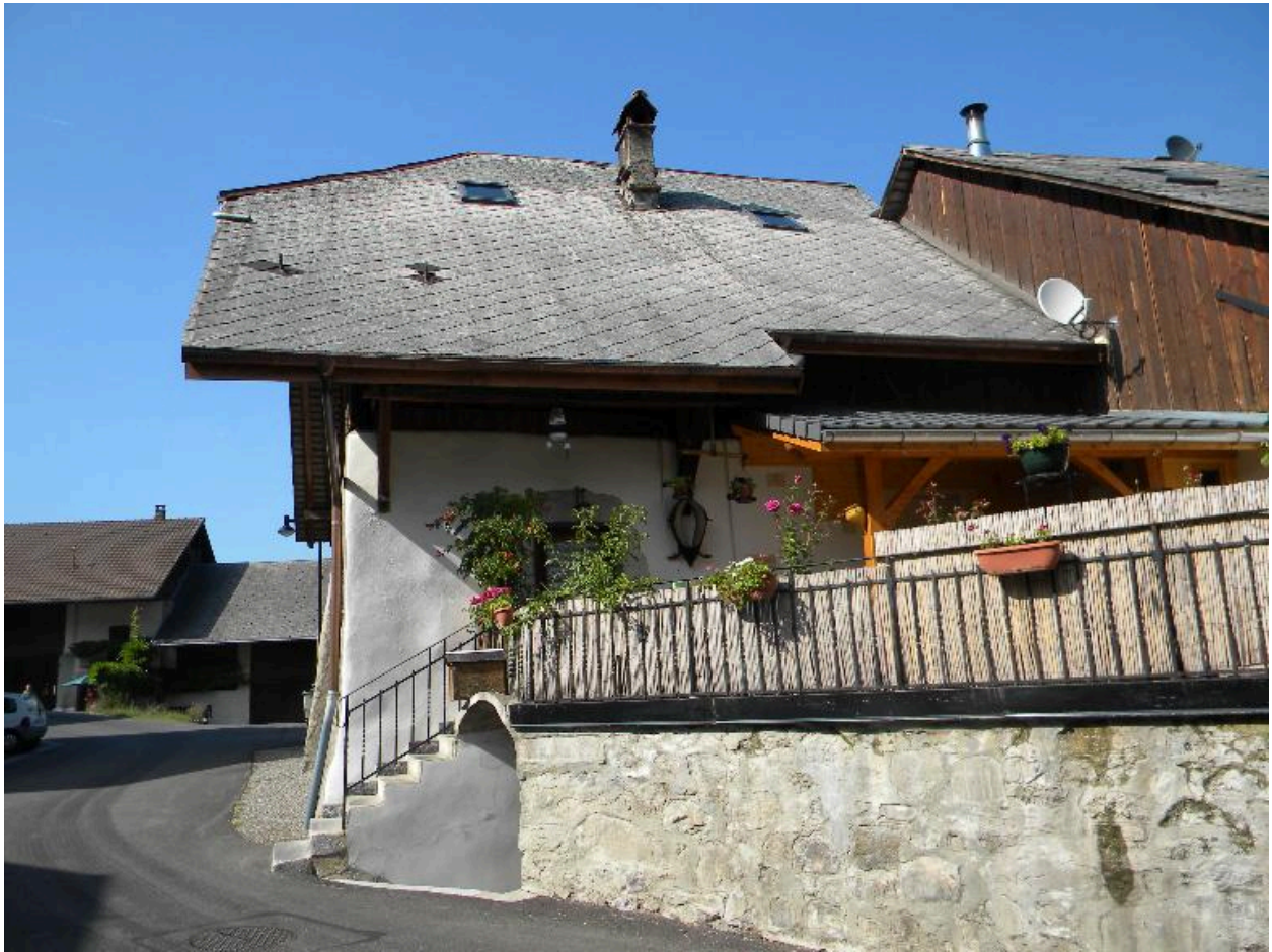
Vue d'une partie modifiée d'un alignement de ferme, façade sud (2008 F7 888, 889, 890, 891)
