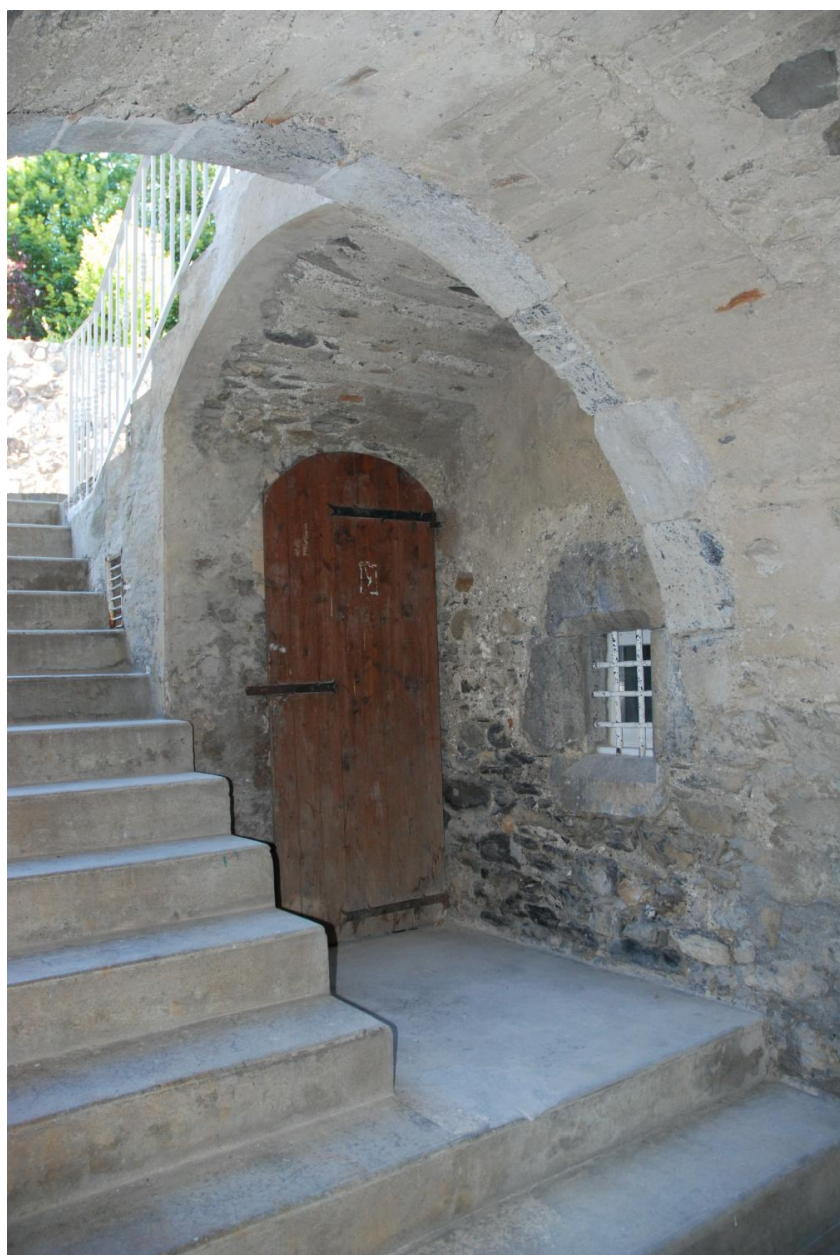
Escalier et vestibule desservant l'étage de soubassement.
