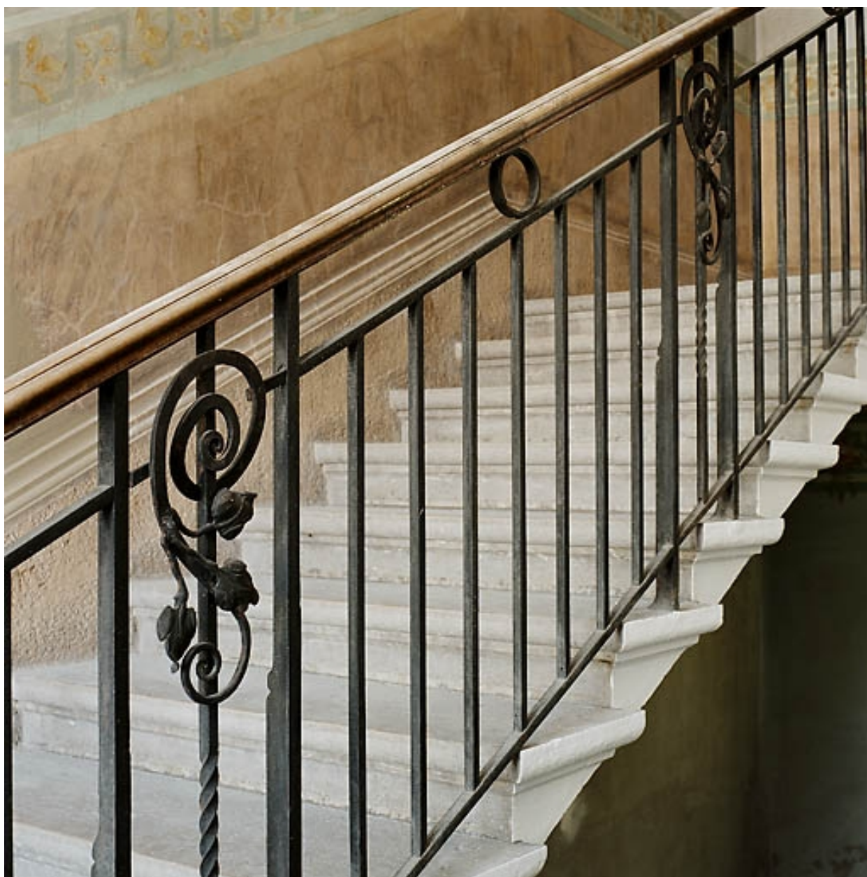
Ferronnerie rampe d'escalier
