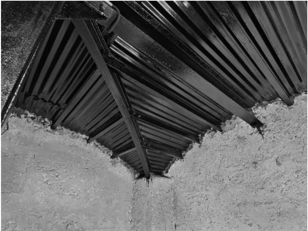
Caves, détail d'une voûte
