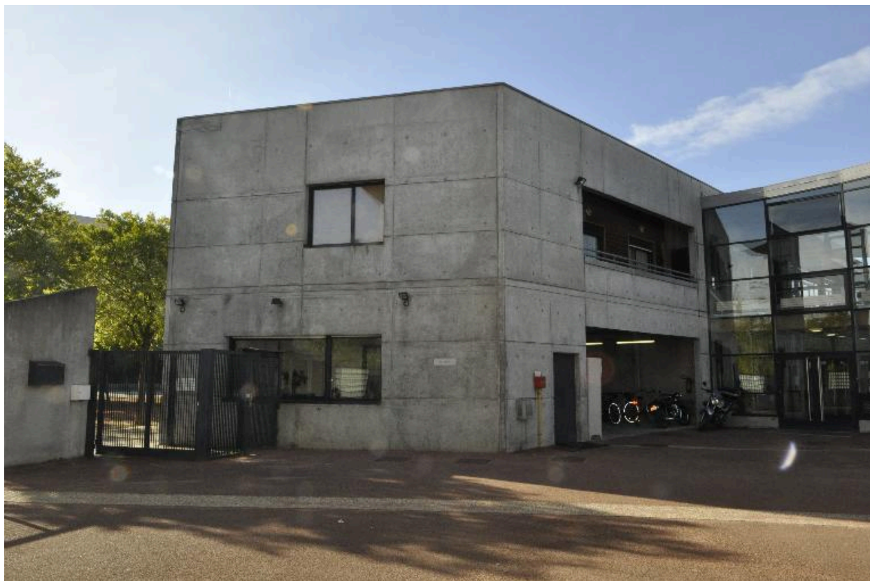
Entrée du lycée : loge du gardien
