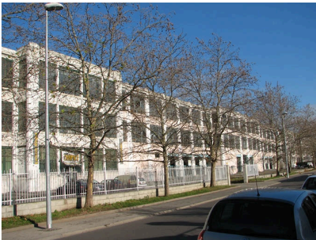
Vue d'ensemble ouest
