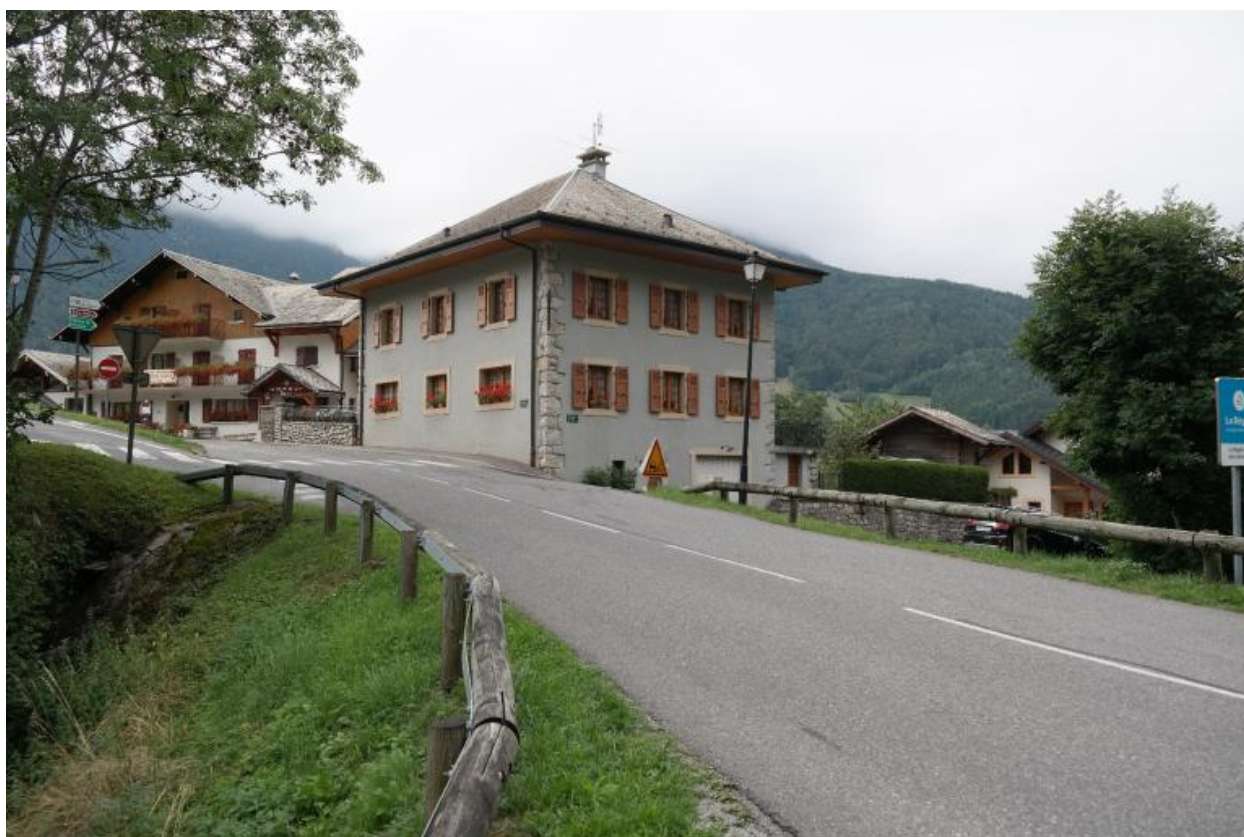
Vue générale du pont du Chef-Lieu
