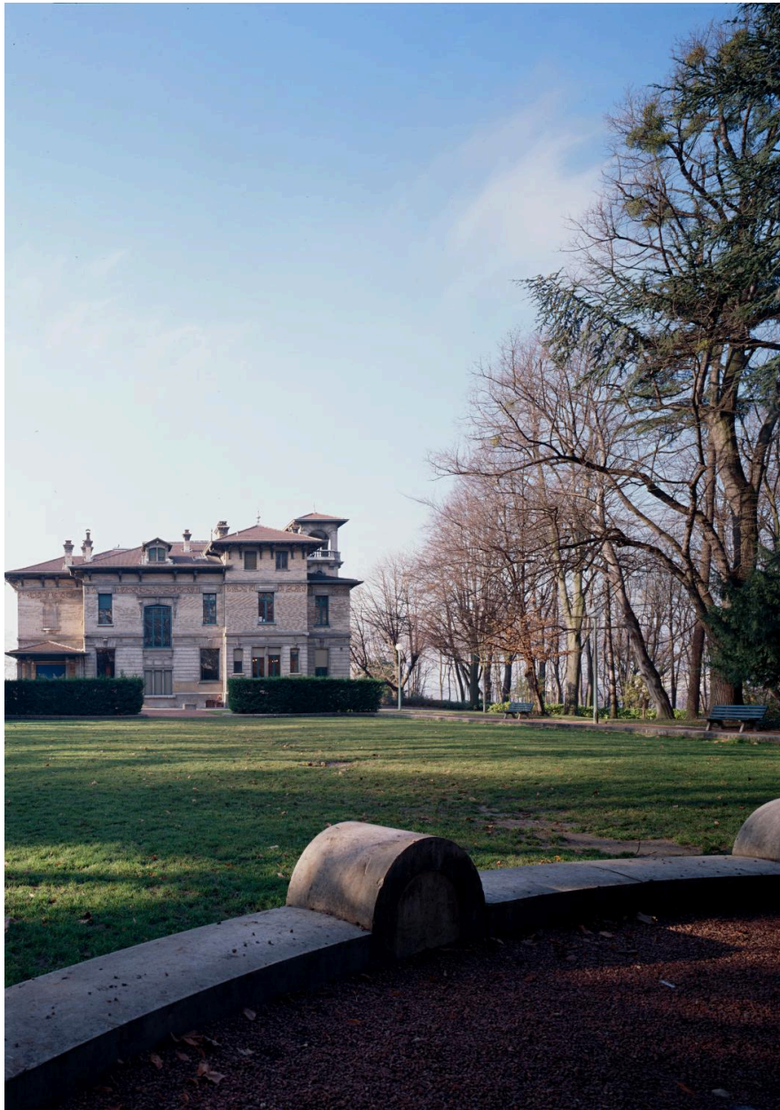
Vue d'ensemble prise depuis l'entrée du parc (façade orientale)
