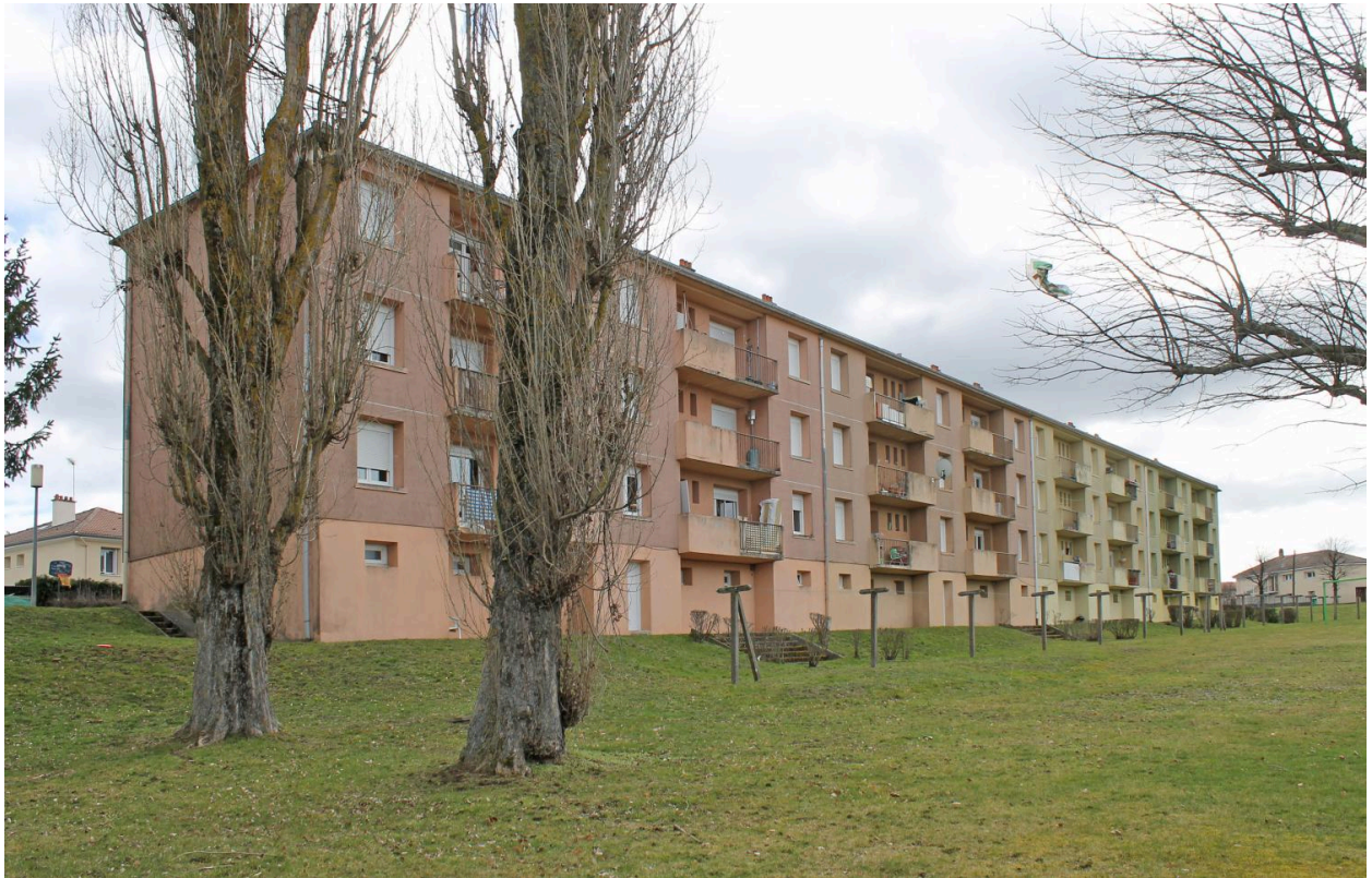
Sainte-Sigolène : les immeubles HLM de la Croix-Saint-Romain et le lotissement Les Érables, le « Groupe 2 » vu du nord-ouest.
