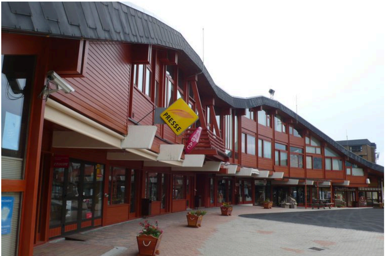
La galerie ouverte sur la place à l'est
