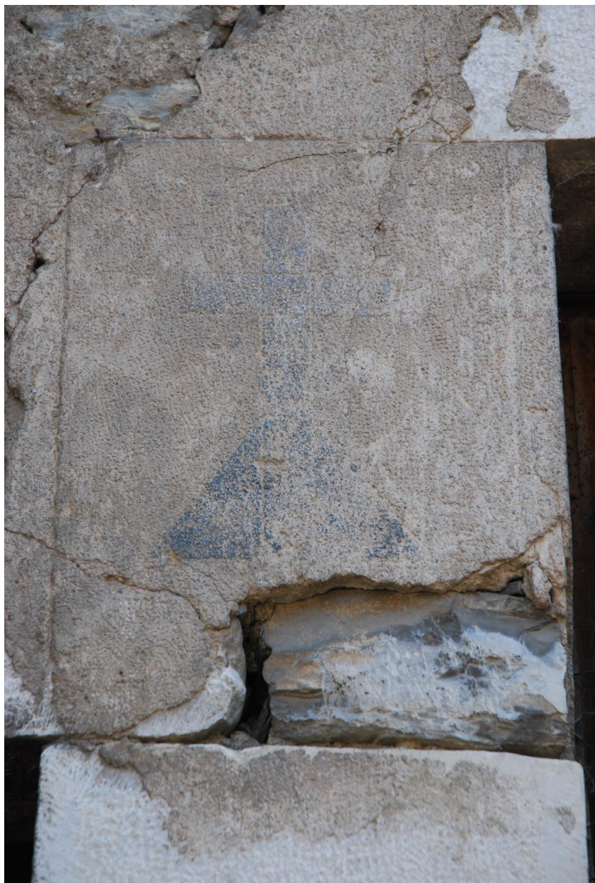
Elévation ouest, détail : croix gravée et peinte en bleu sur le jambage de la fenêtre.
