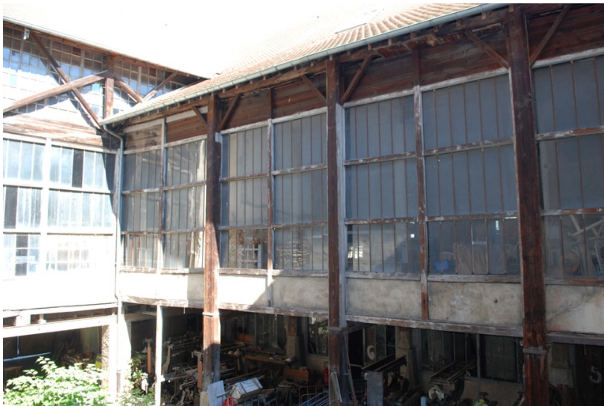
Vue extérieure atelier de menuiserie
