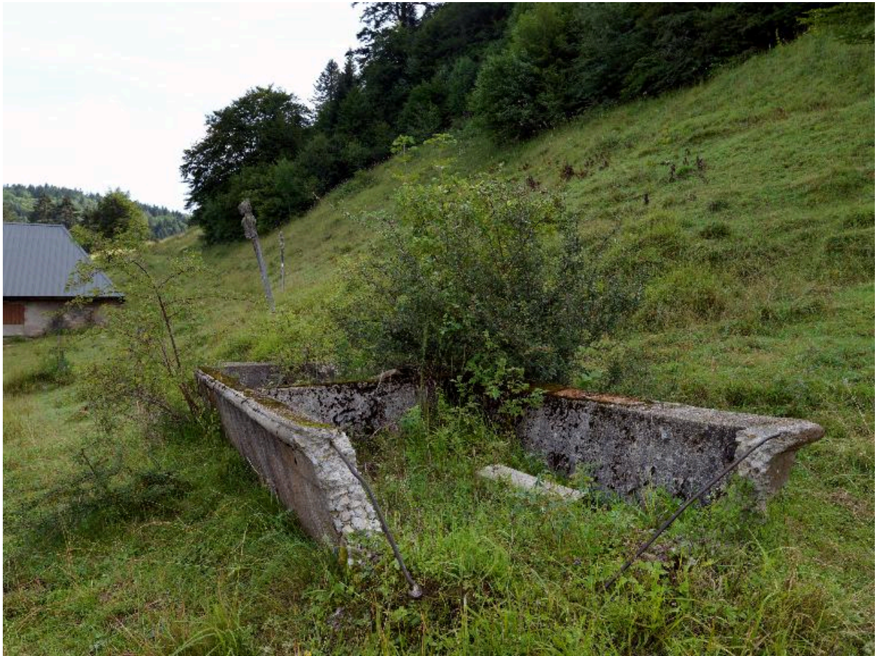
Vue du bassin (fontaine-abreuvoir).
