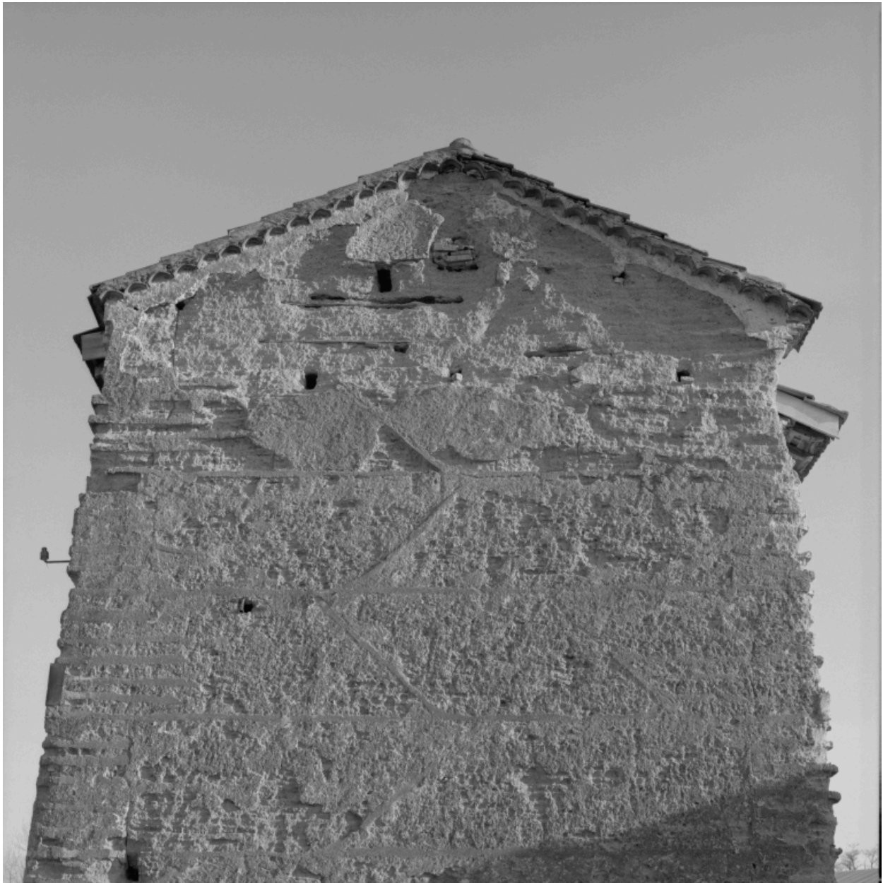
Colombier, détail du pisé du pignon gauche.
