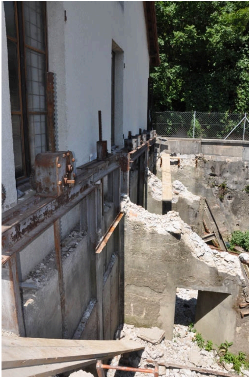
Vue de la façade est de la centrale avec le système de vannage
