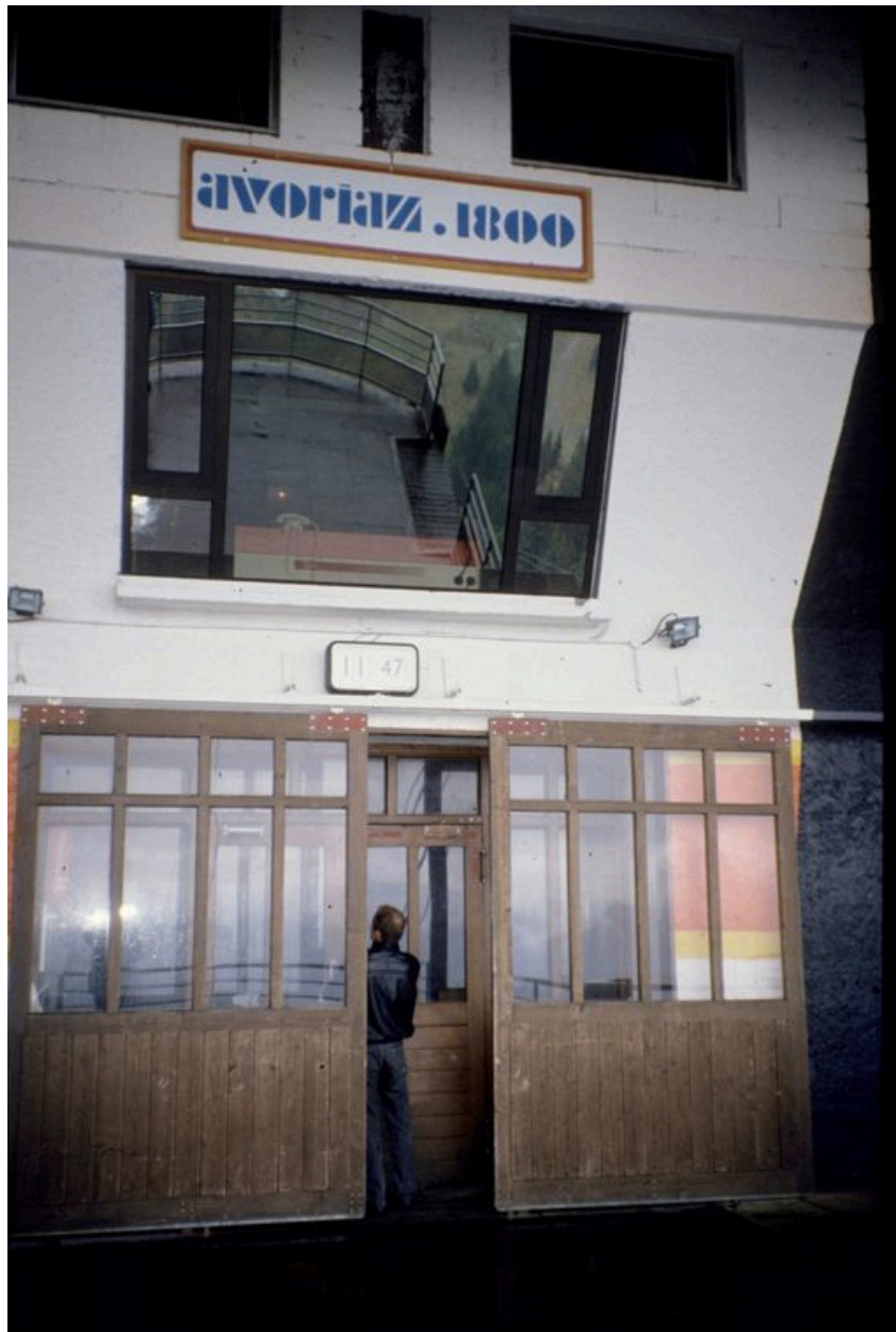
Accès au poste de commandement. Photogr. 1989
