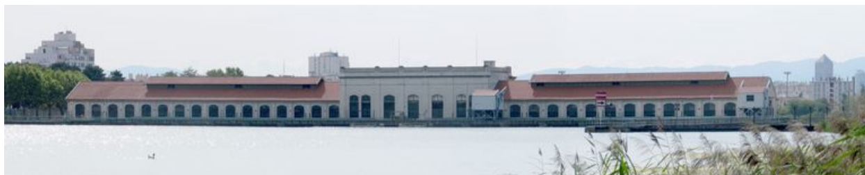
Vue panoramique, face amont (depuis la rive droite)
