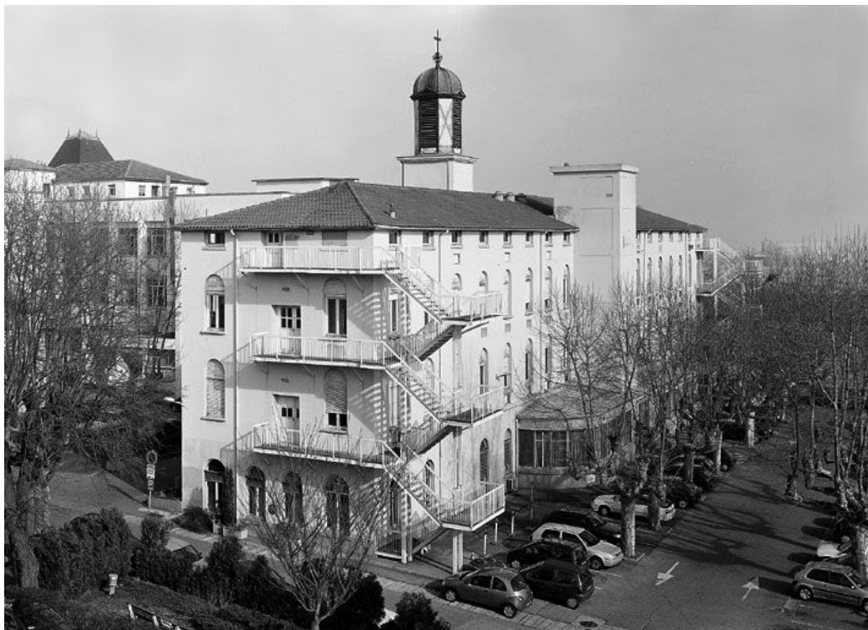
Pavillon de l'Horloge (22), vue générale des élévations ouest et sud
