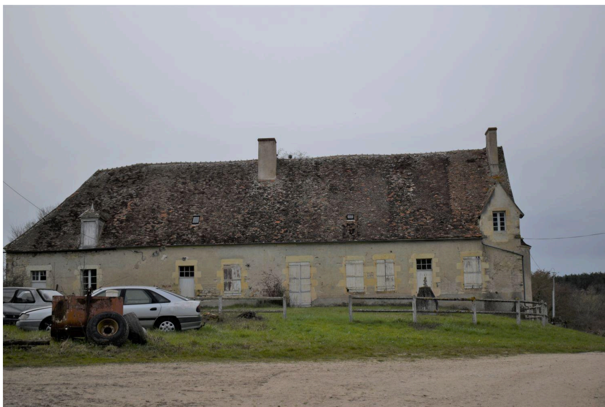
Vue générale de l'ancien logis façade est.
