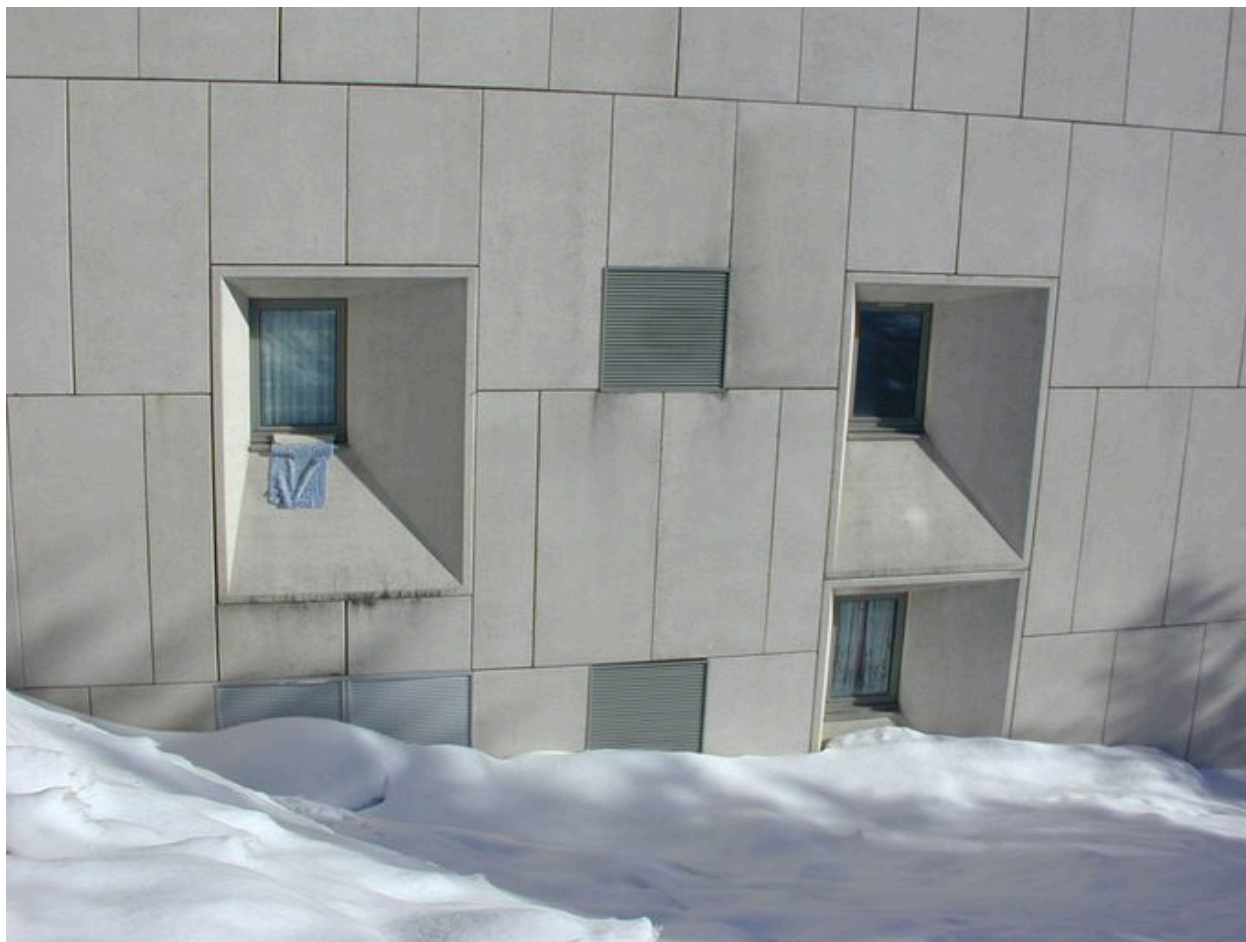
Détail des baies de la façade nord
