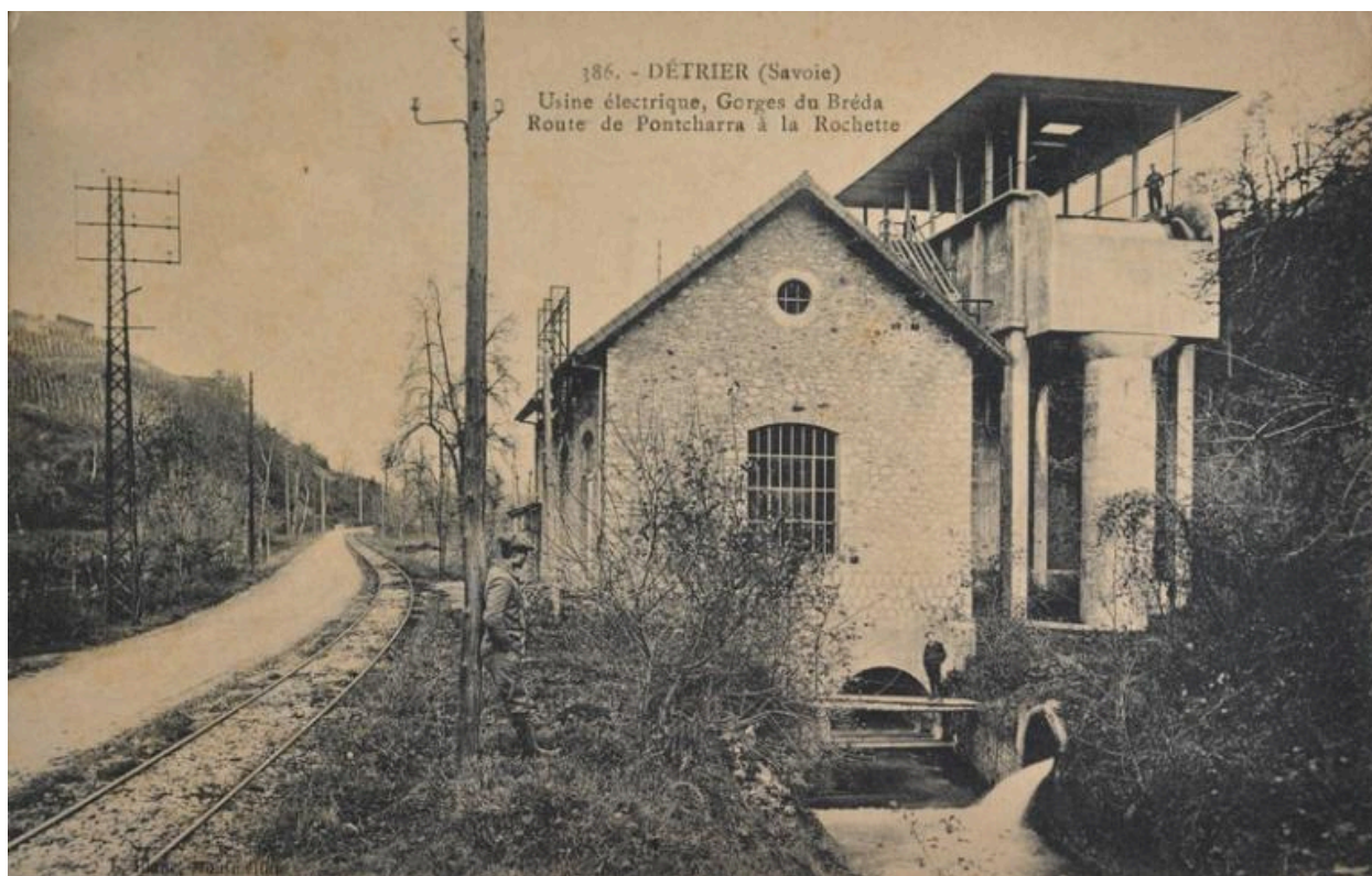
Vue ancienne de la centrale de Détrier (© Collection particulière M.-A. Podevin).
