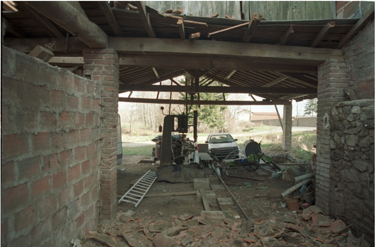
Vue d'ensemble de la scierie désaffectée.
