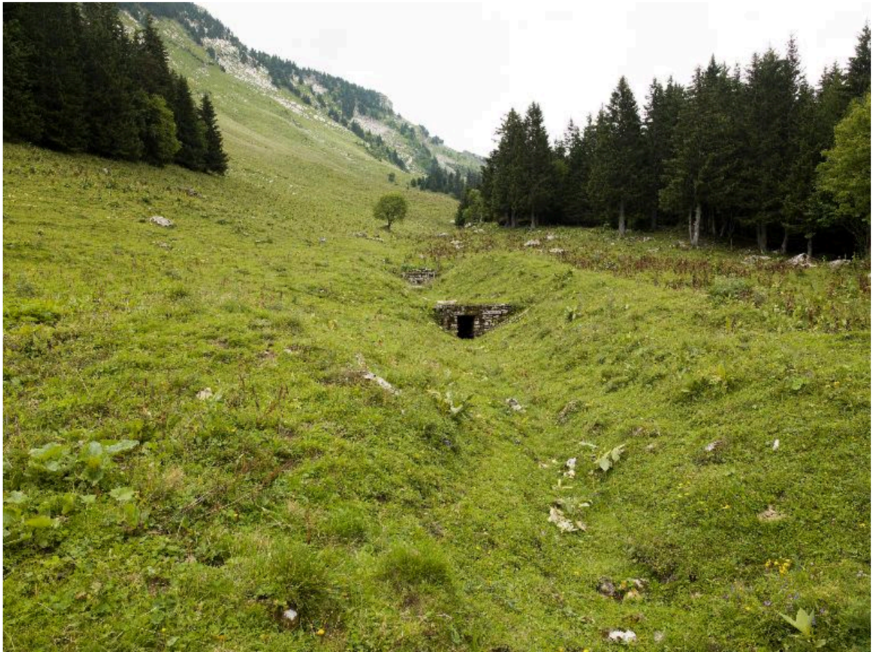
Vue de l'alpage de l'Arclusaz : la prise d'eau (les Arbets, 2016 B4 274, non cadastré).
