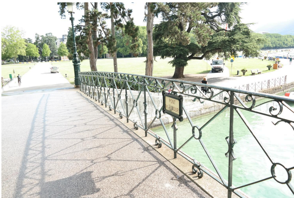
Passerelle du jardin public, dit Pont des Amours, vue de la chaussée
