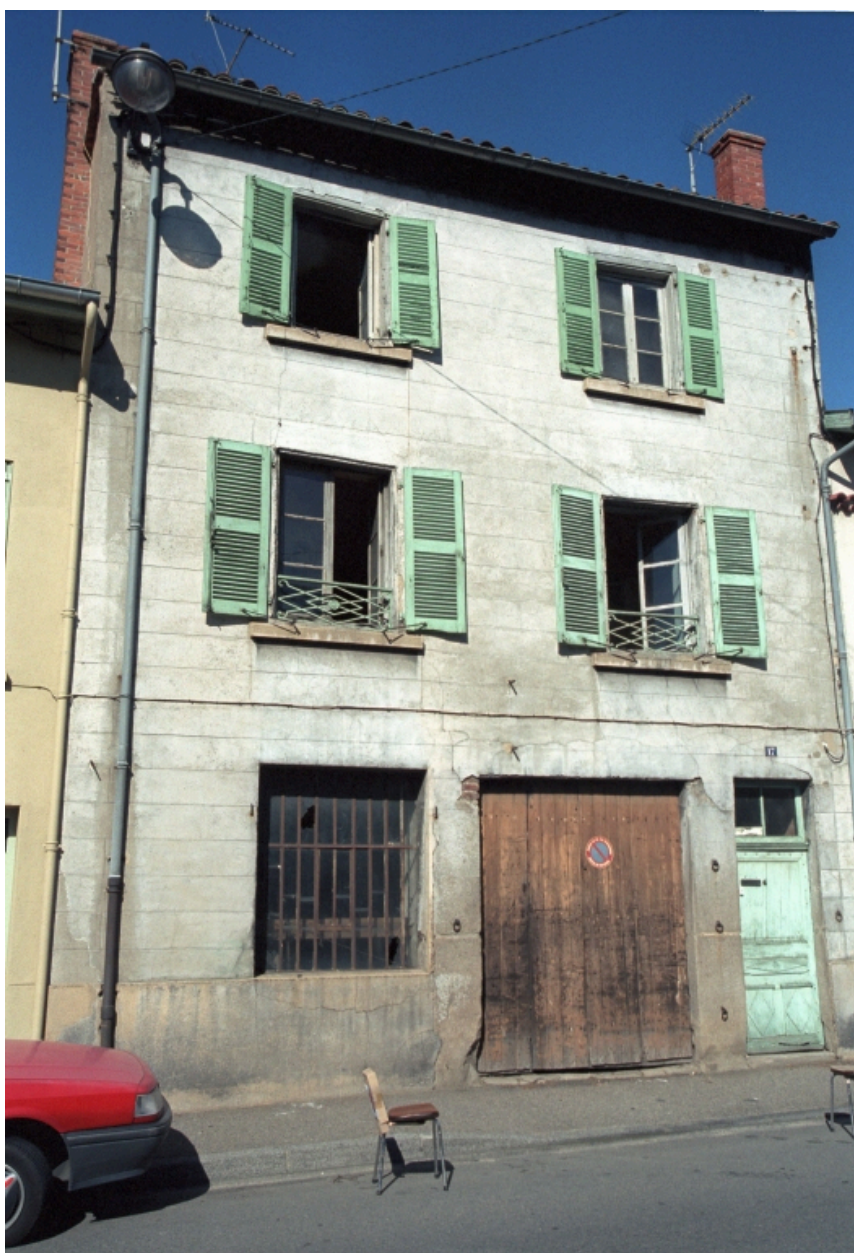
Boën, îlot 11, Clermont (rue de) 17. Vue générale de la façade sur rue.
