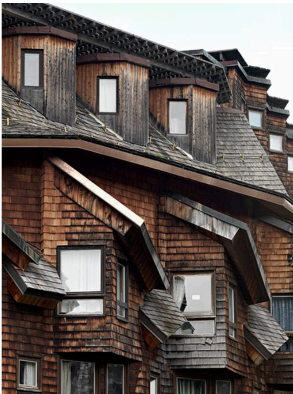
Façade nord. Détail
