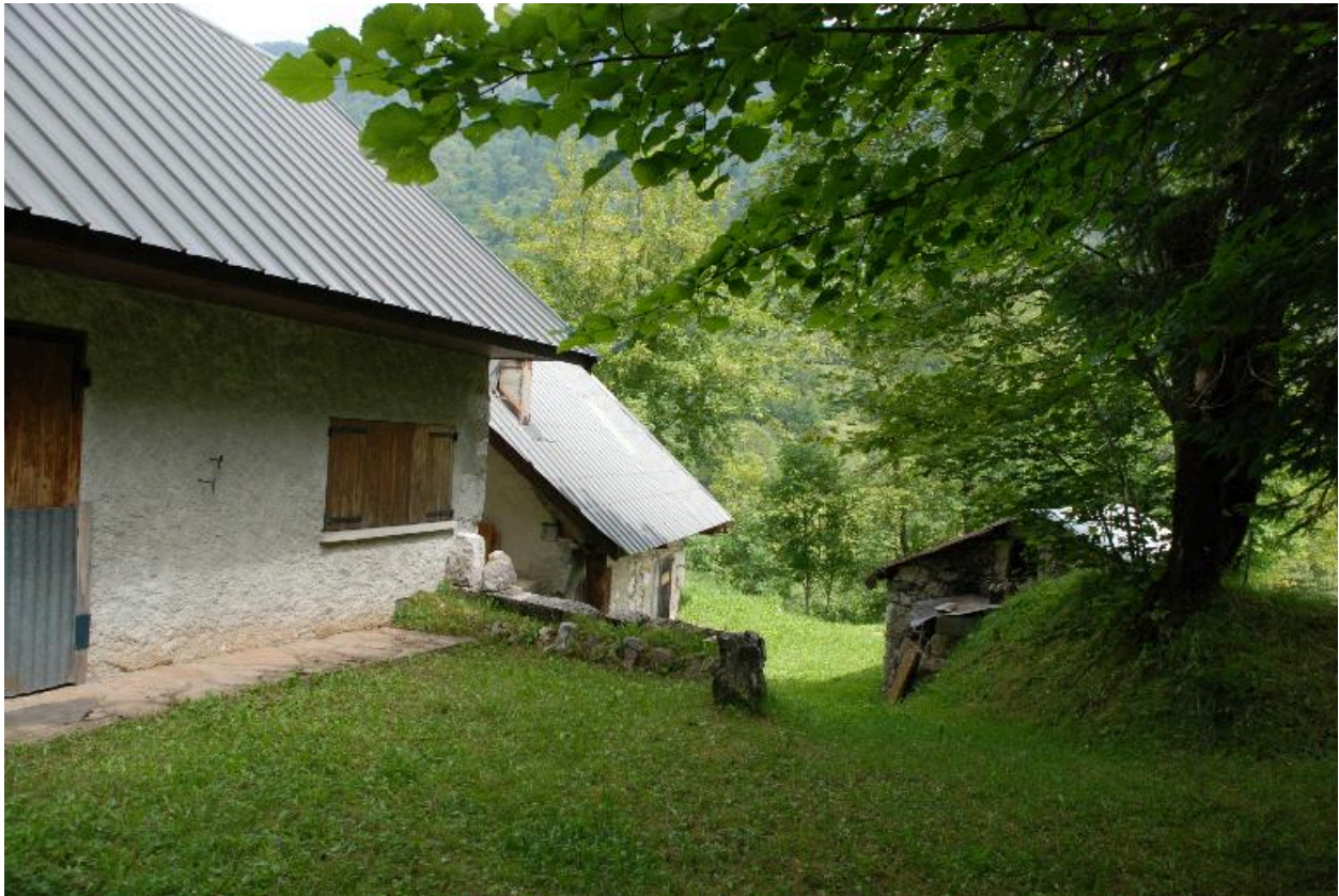
Vue de chalets (2016 G9 1026 et 1027) aux Chalets des Chausses, depuis l'ouest (non repérés).
