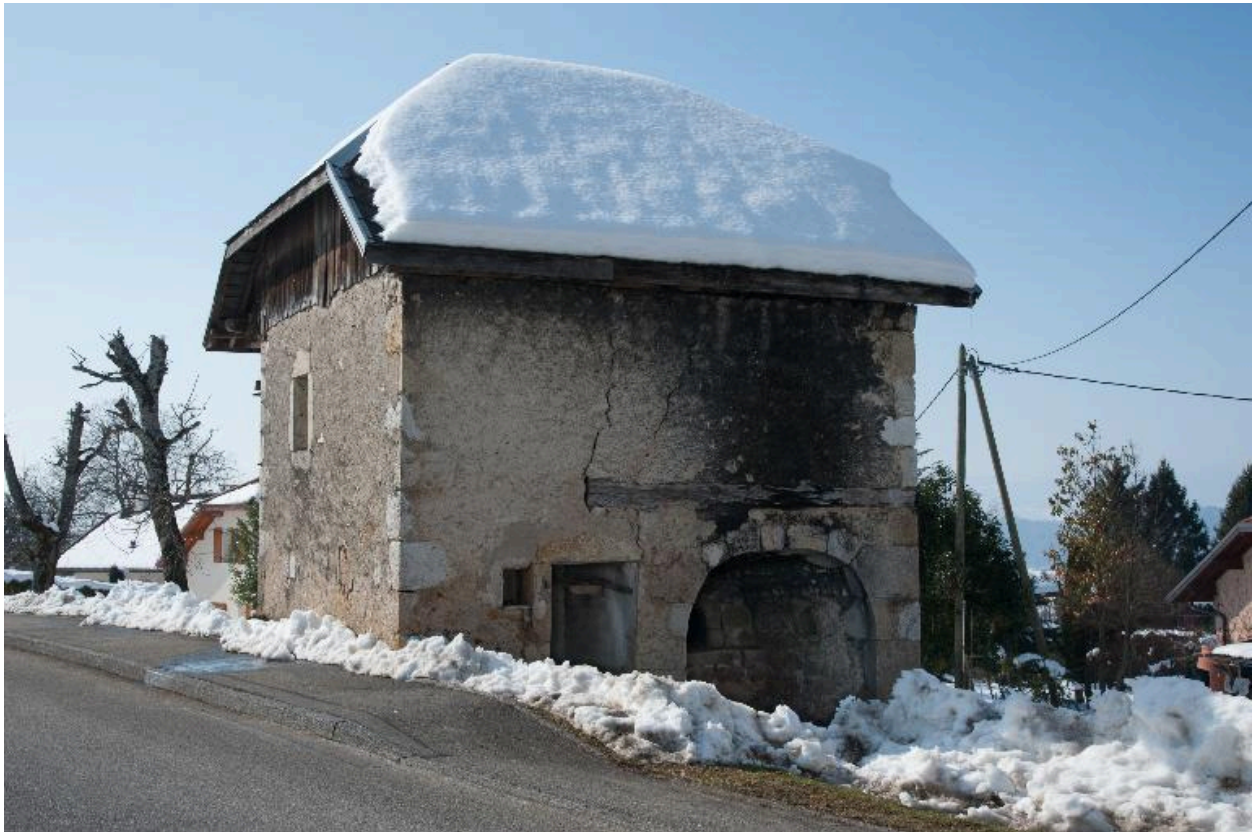
Vue d'ensemble depuis la route de Viuz-la-Chiesaz.
