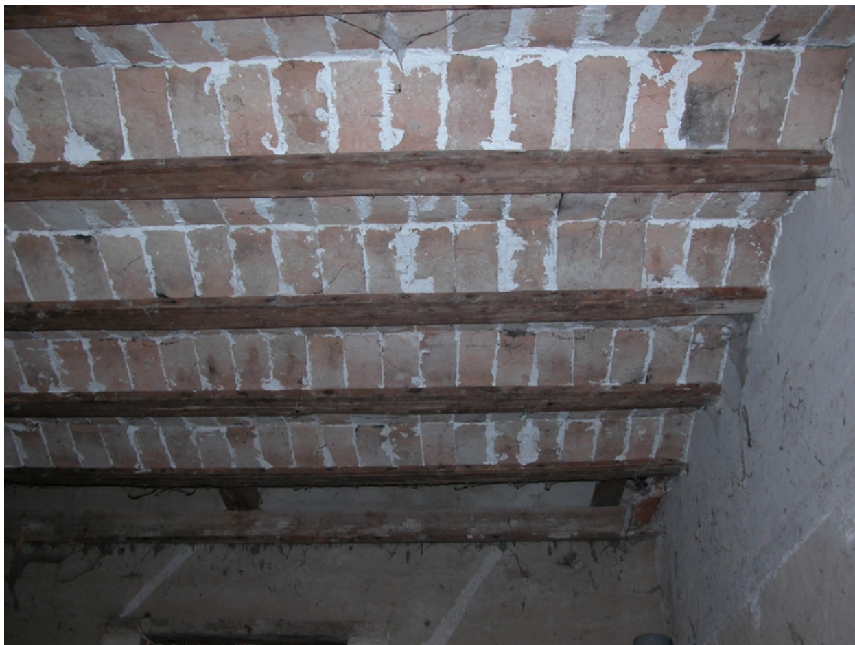
Plafond de la remise à betteraves.
