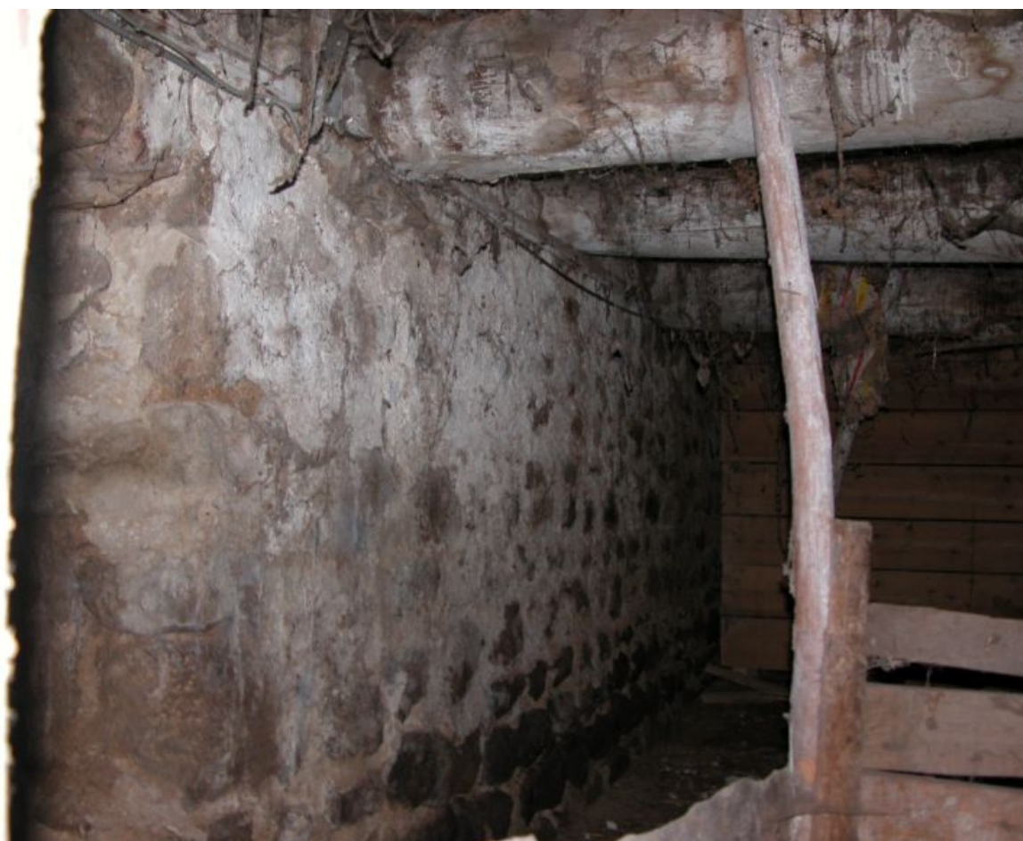
Grange-étable. Vue partielle intérieure, mur est.
