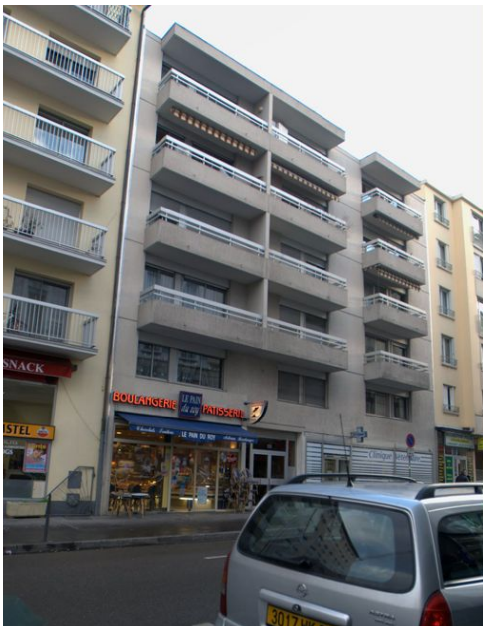
Elévation antérieure, depuis le sud-ouest
