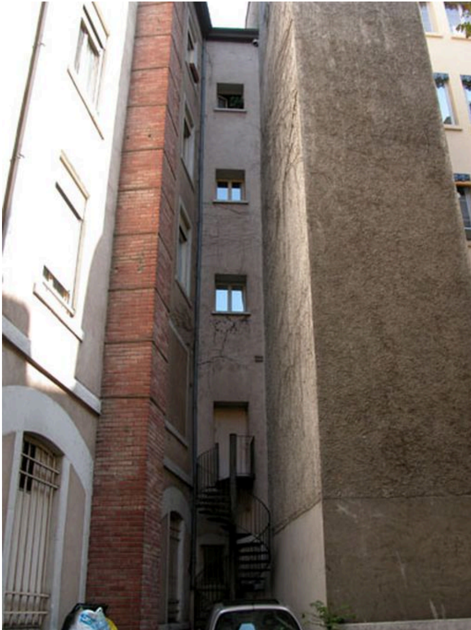
Elévation postérieure, côté nord
