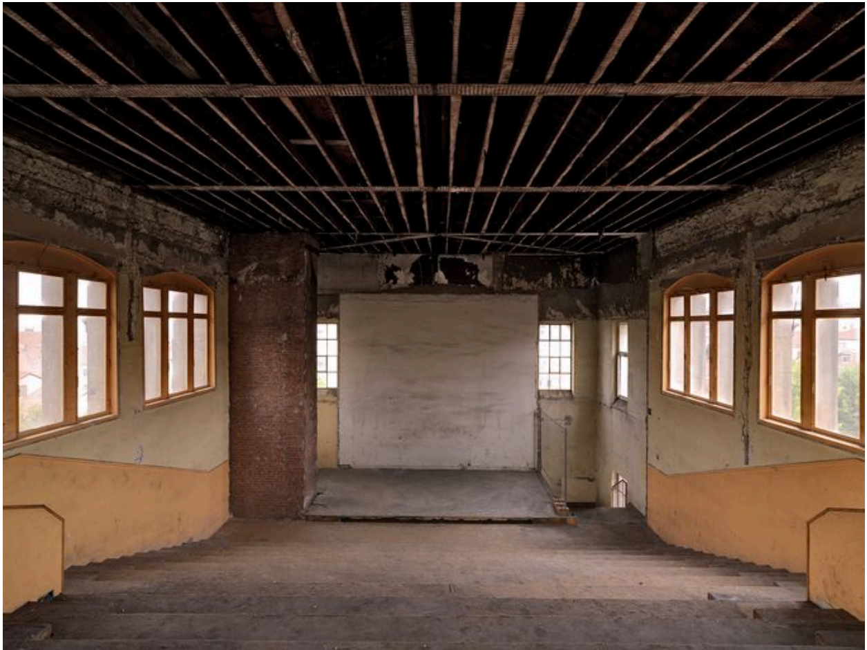
Vue intérieure de l'amphithéâtre en avril 2011, après l'enlèvement des sièges.
