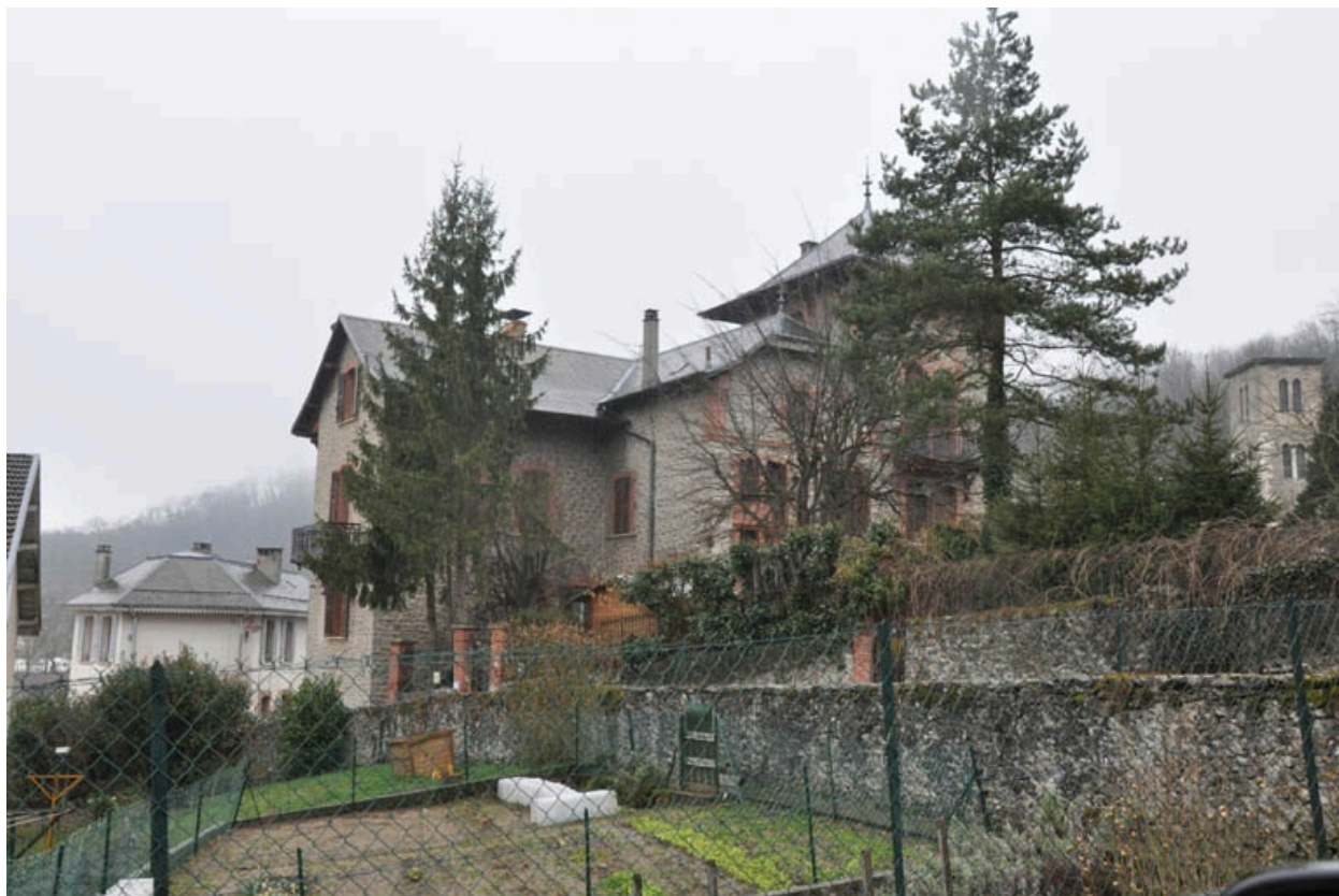
Vue du logement patronal, façades sud et est
