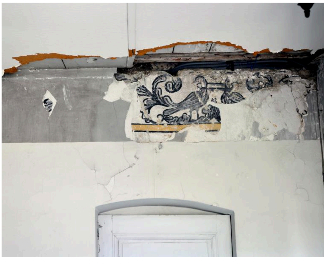
Mur nord : détail du décor peint sous-jacent
