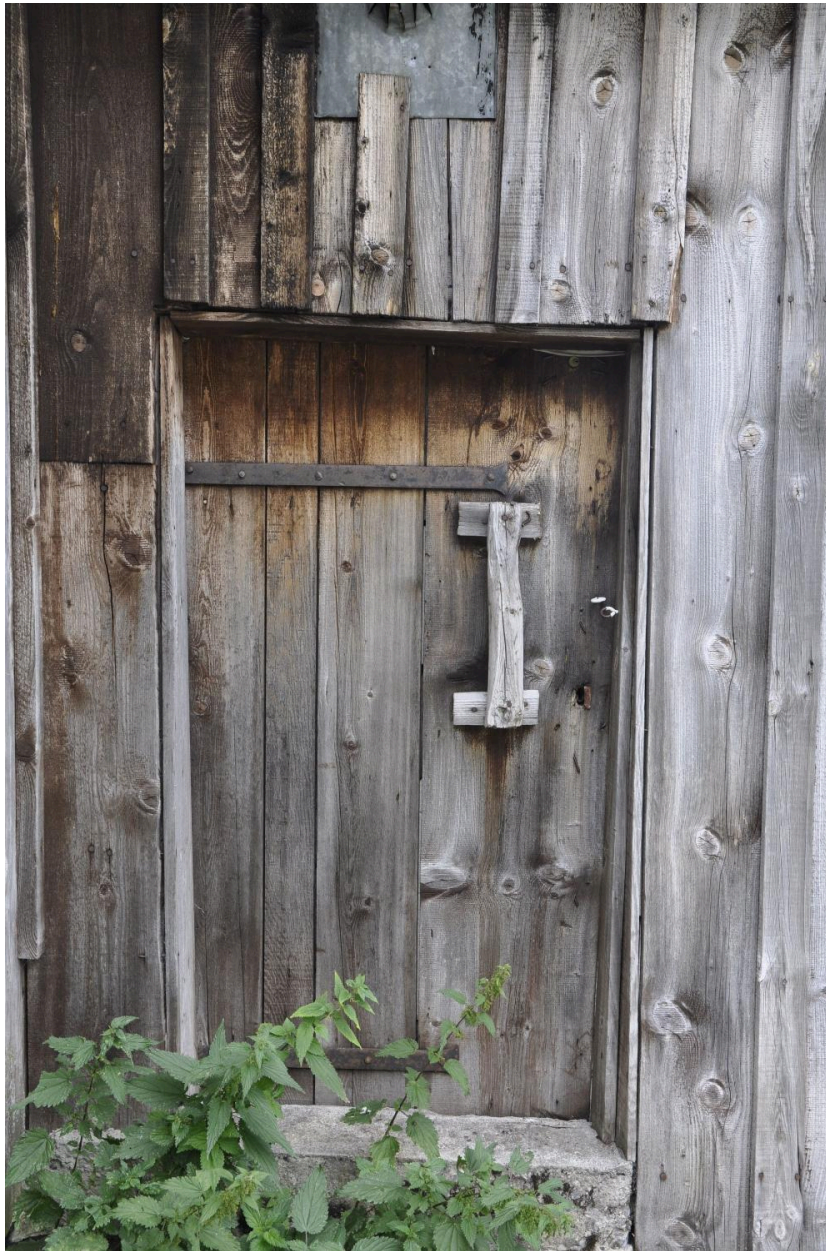
Détail de la porte d'entrée
