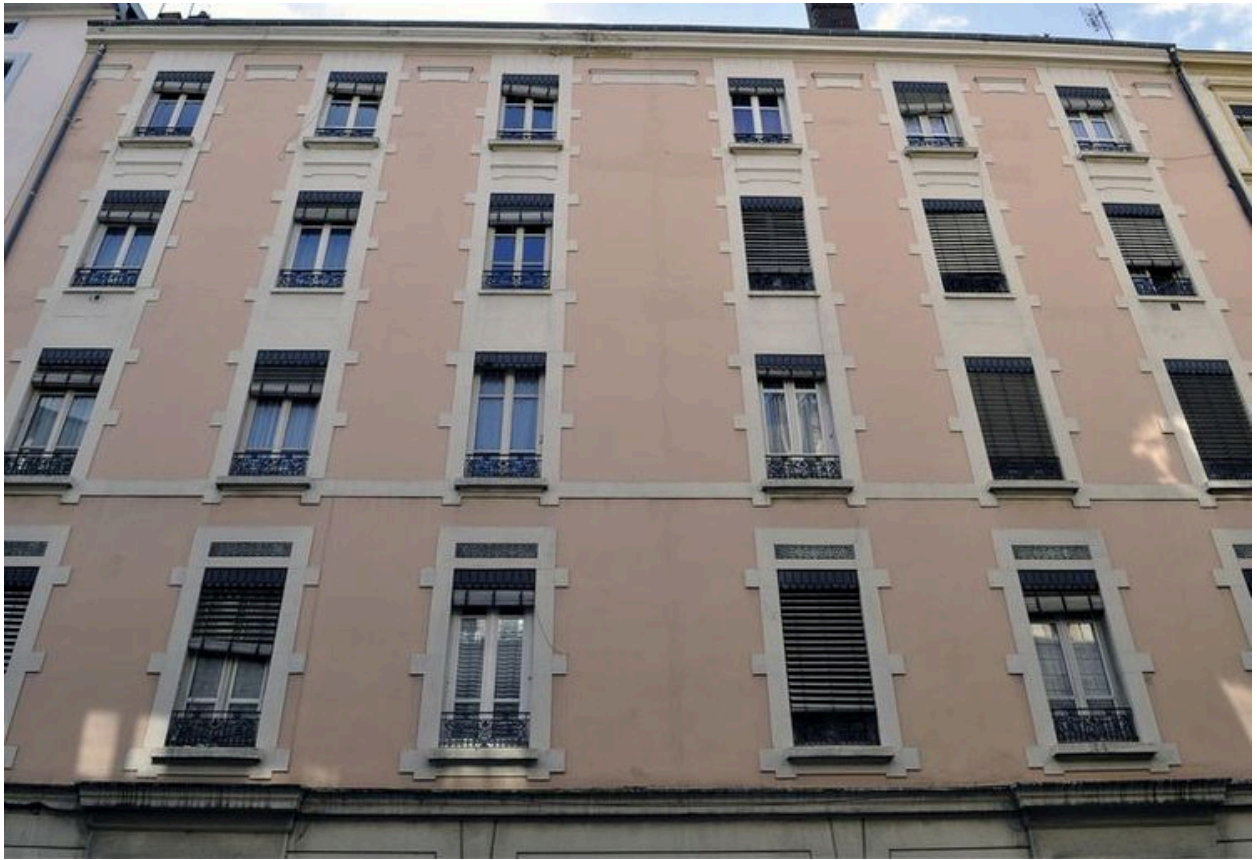
Façade antérieure : baies des étages
