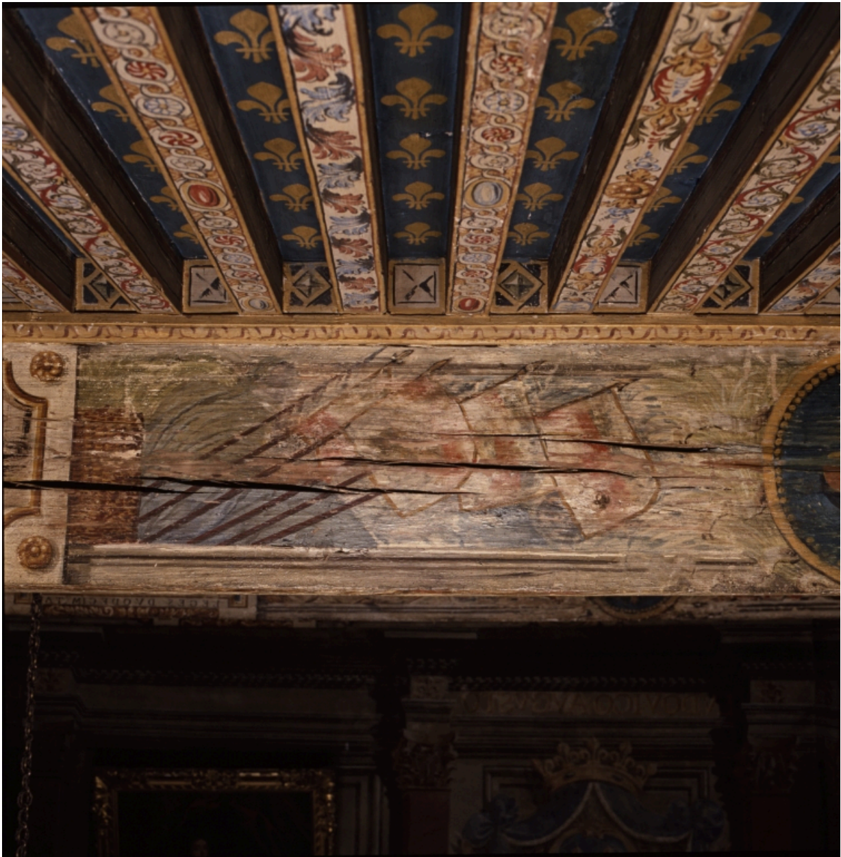
Poutre 3, face sud, centre gauche : trophées de victoire.
