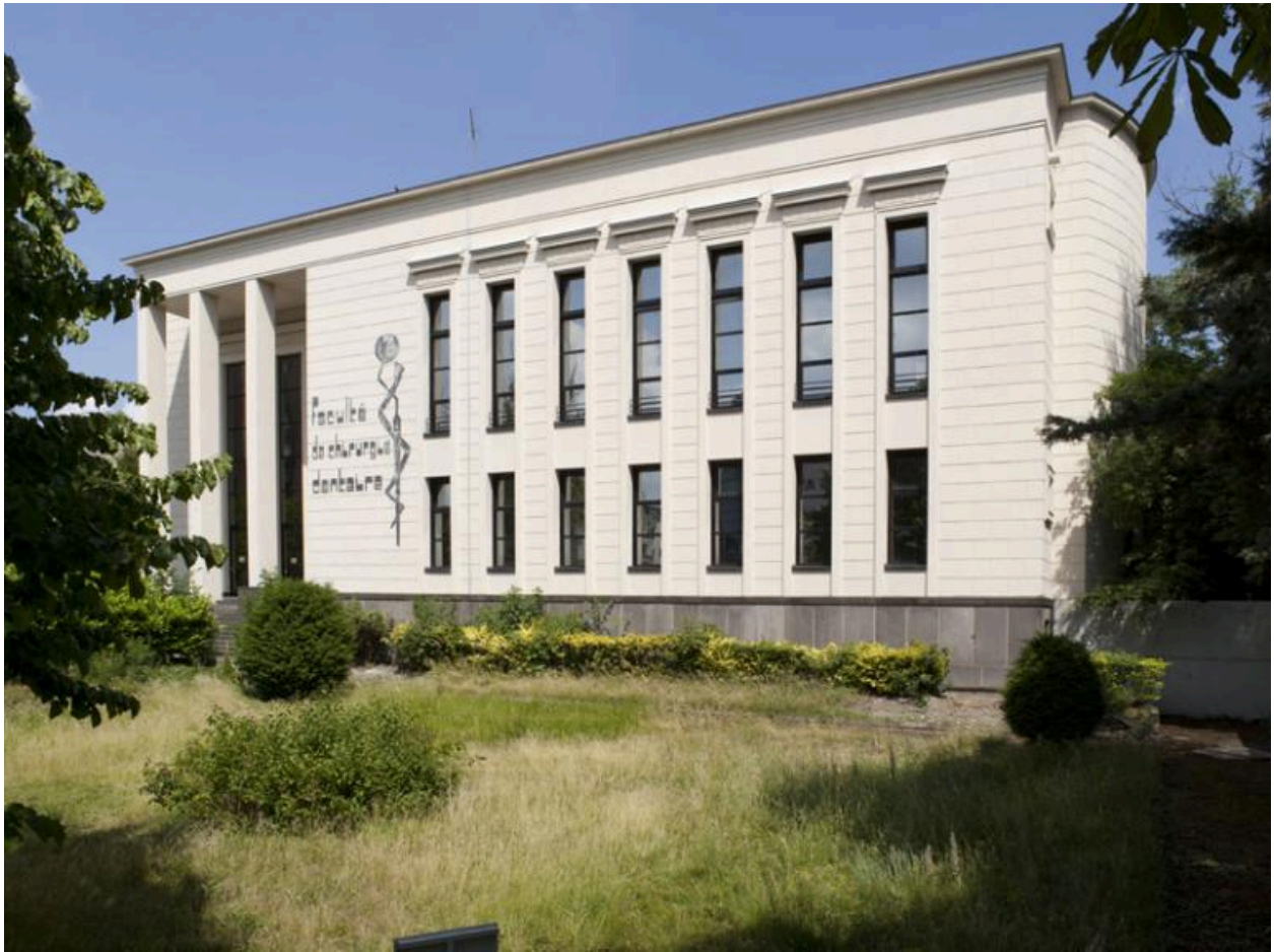
Hôtel-Dieu de Clermont-Ferrand. La faculté d'odontologie, façade principale vue du sud-ouest.
