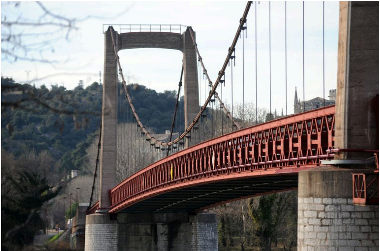
Vue partielle, de côté, travée centrale, face aval (depuis la rive gauche)
