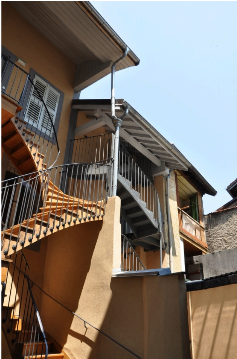
loggia devant façade postérieure
