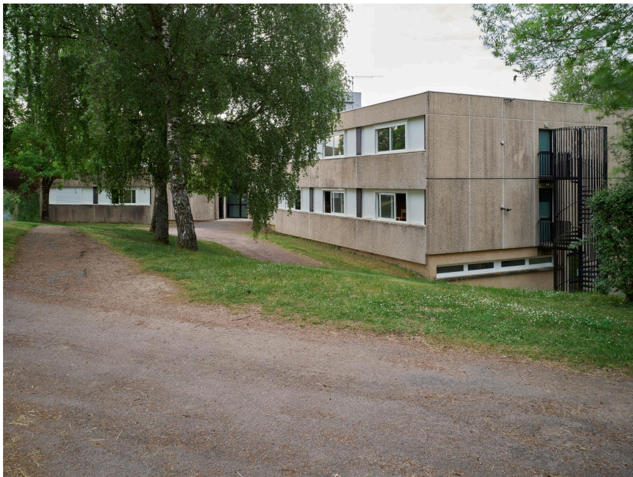
Bâtiment de l'internat depuis le nord-ouest.
