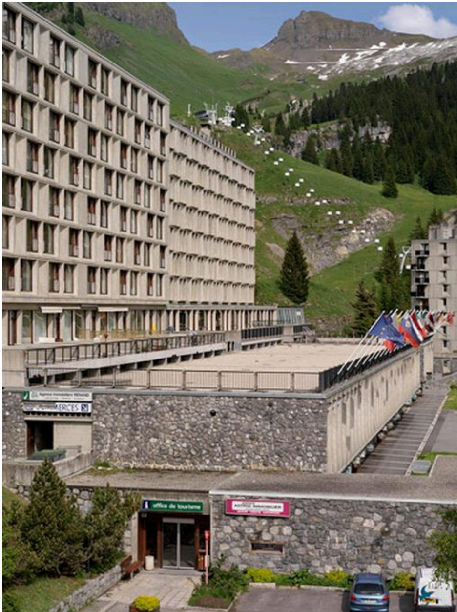
Vue depuis l'ouest-sud-ouest
