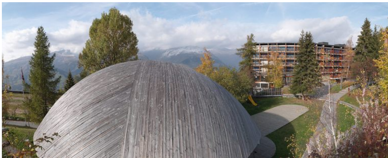
Vue générale depuis le sud
