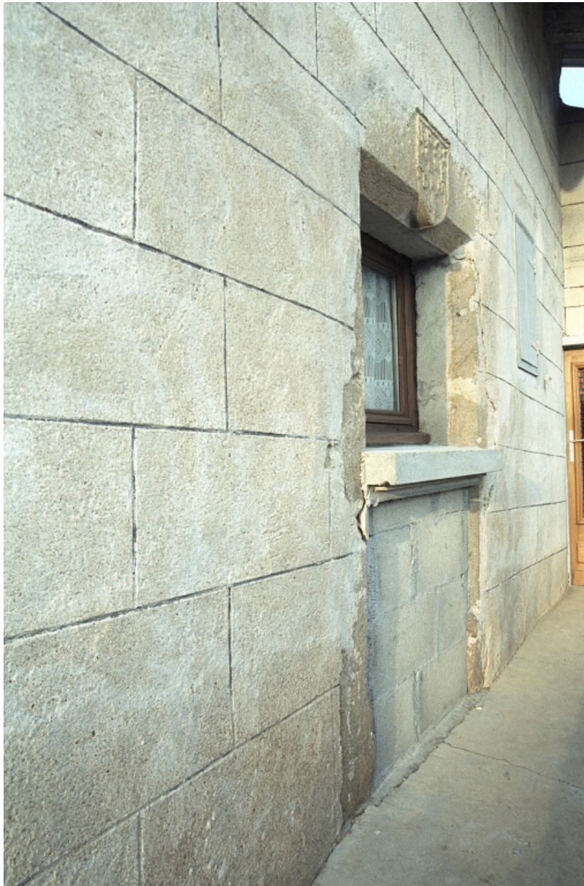
Ferme au bourg (ancien presbytère ? 1986 A1 76). détail de la porte d'entrée.
