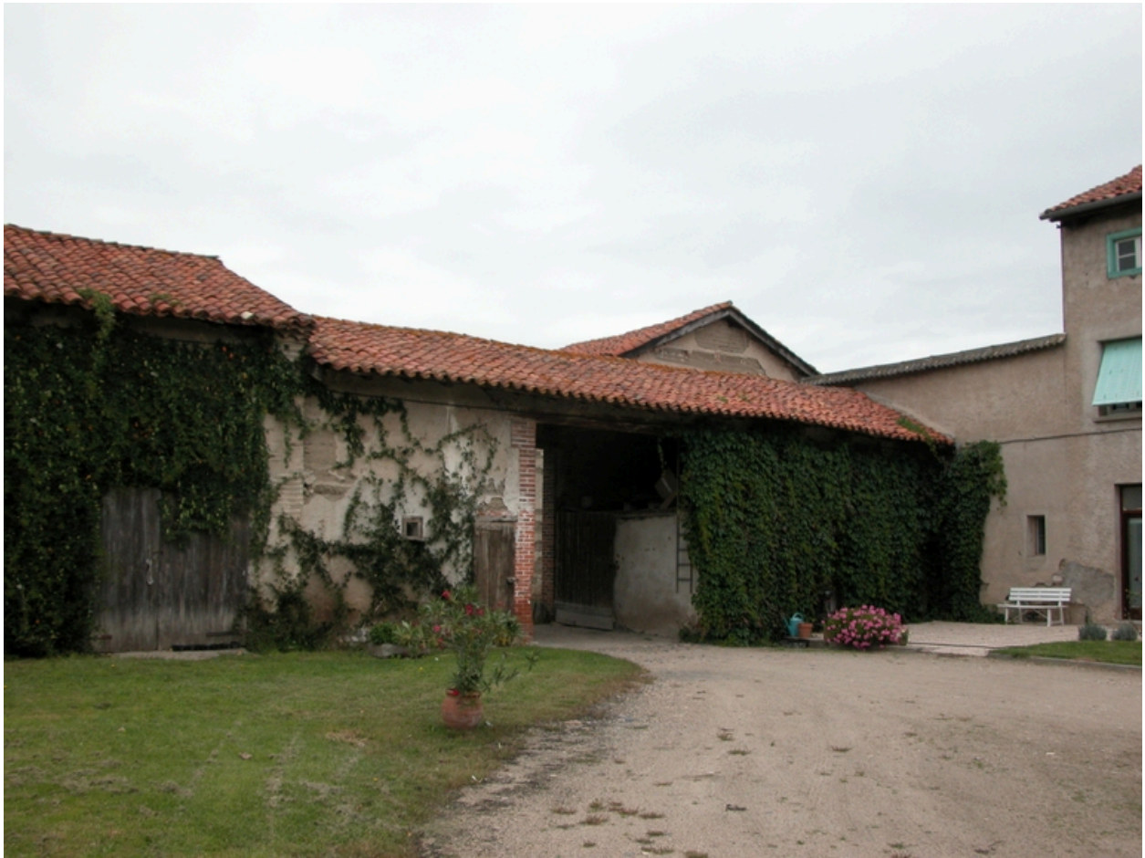
Vue du bâtiment nord : remise, atelier, passage couvert, poulailler.
