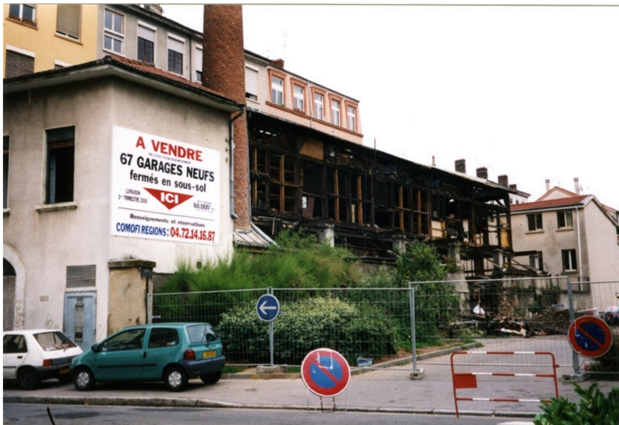
Vue générale est, rue de Cuire (existe en ZE)
