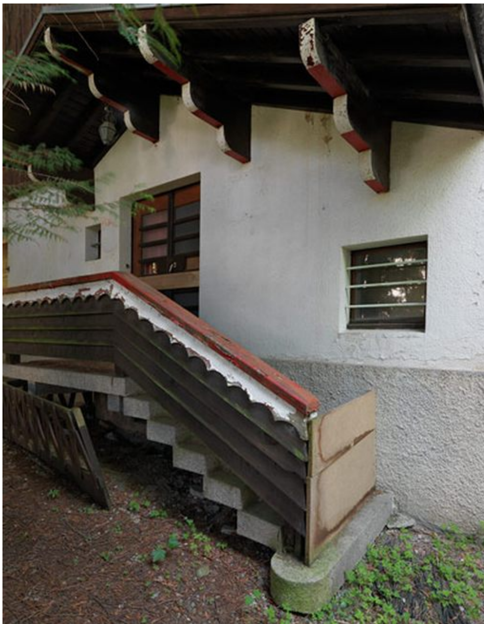
Elévation nord. Partie postérieure avec escalier et perron d'entrée
