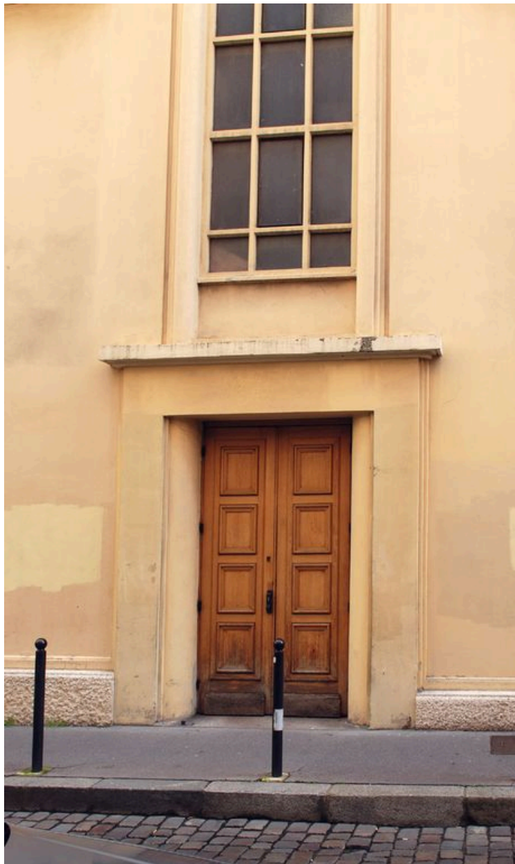
Elévation latérale sud détail de la porte donnant sur l'escalier sud
